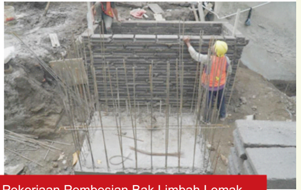
Pekerjaan Pembesian Bak Limbah Lemak
