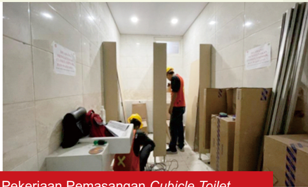
Pekerjaan Pemasangan Cubicle Toilet
