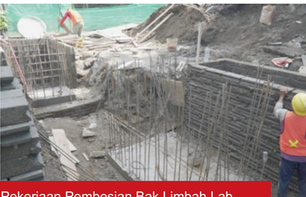
Pekerjaan Pembesian Bak Limbah Lab
