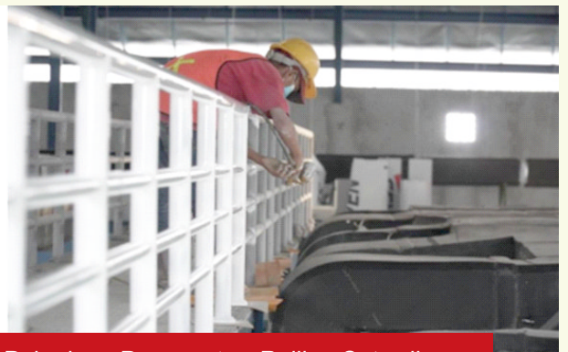
Pekerjaan Pengecatan Railing Catwalk
